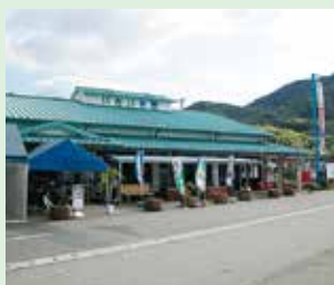
道の駅「ようしみいきいき館」
