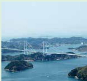
来島海峡大橋
