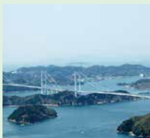
来島海峡大橋
