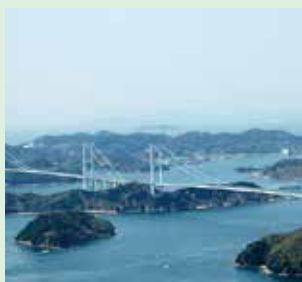
来島海峡大橋
