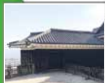
隠門続櫓 (かくれもんつぎやぐら)
